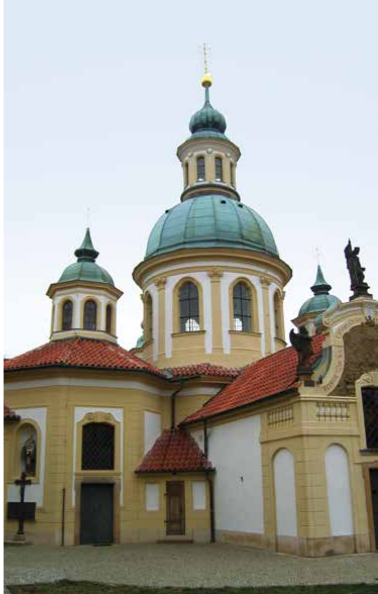
Poutní kostel Panny Marie Vítězné na Bílé Hoře – obnova fasády kostela.
